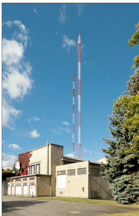
Sendestelle Britz: im Herbst 2012 noch mit zwei MW-Masten
